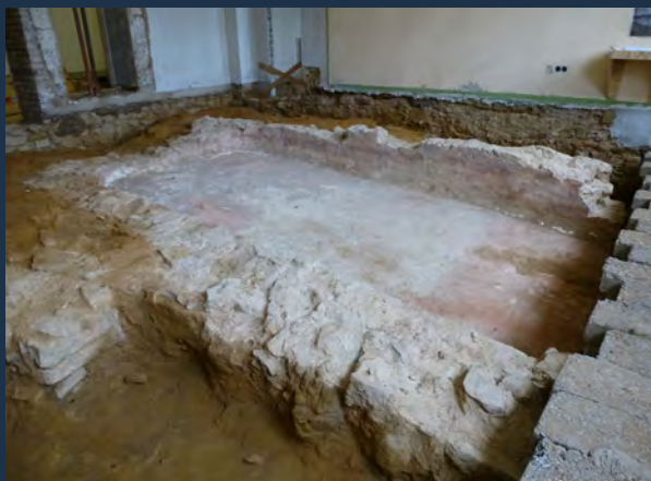
Bassin d'eau entièrement enduit d'un mortier imperméable. Sur les parois sont encore visibles les traces de la ligne d'eau, FRVV
